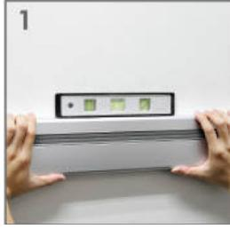
1 Posizionare COV-1 sul muro e utilizzare una livella per ottenere un preciso allineamento orizzontale.
